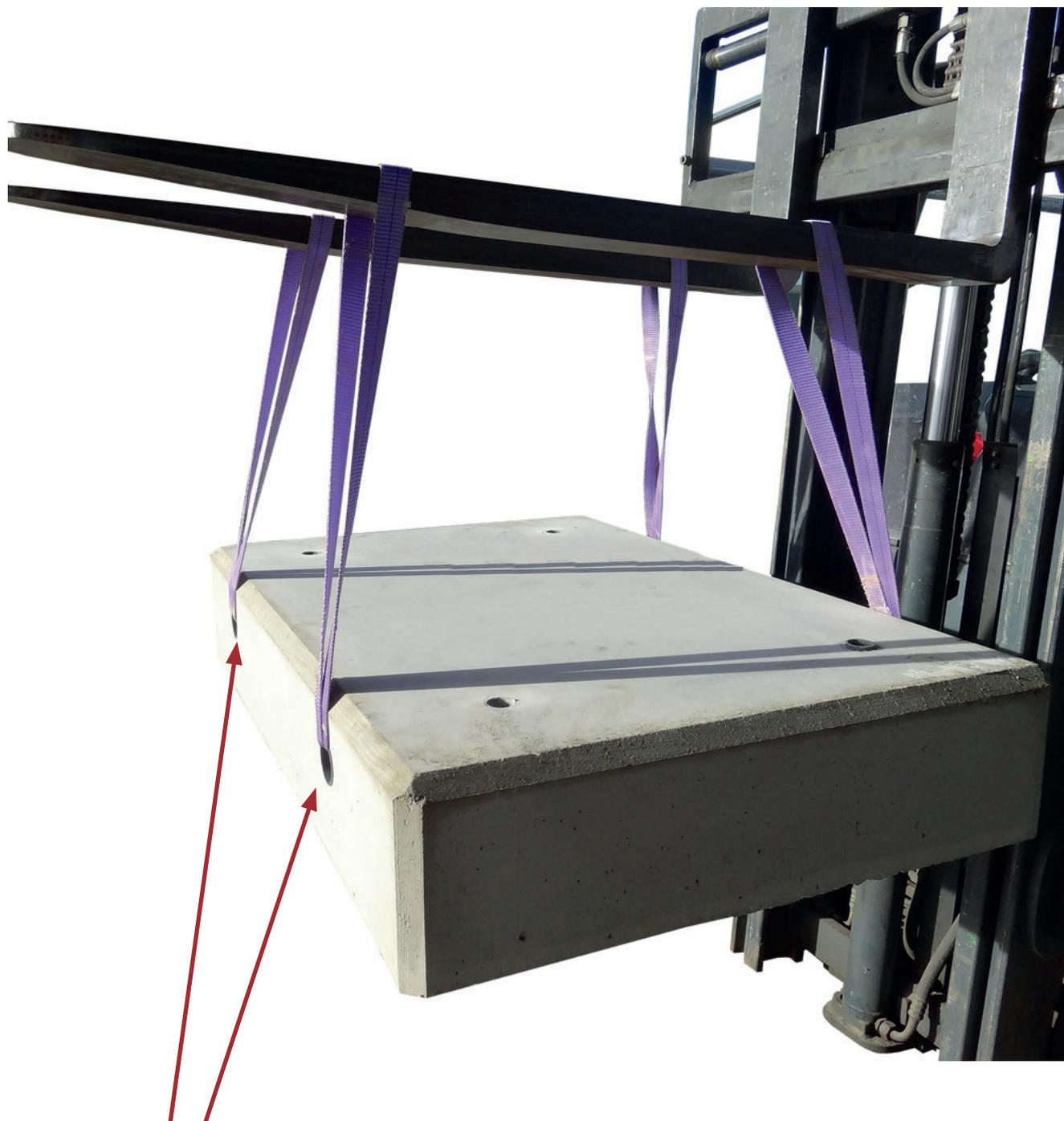
Nutzen Sie für den Transport die vorgesehenen Transportseilführungen, für den Hebeschlupf (bauseitige Bereitstellung) der mind. für eine Hublast von 5t ausgelegt sein muß.
