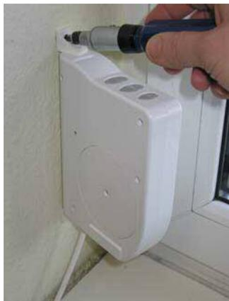
Entfernen Sie den mechanischen Gurtwickler und montieren Sie den Aufputz-Schwenkwickler an dessen Stelle.
